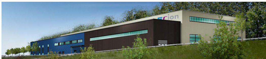
Aperçu du centre de maintenance ERION France à Montceau-les-Mines (71). Inauguration jeudi 20 juin 2019.
